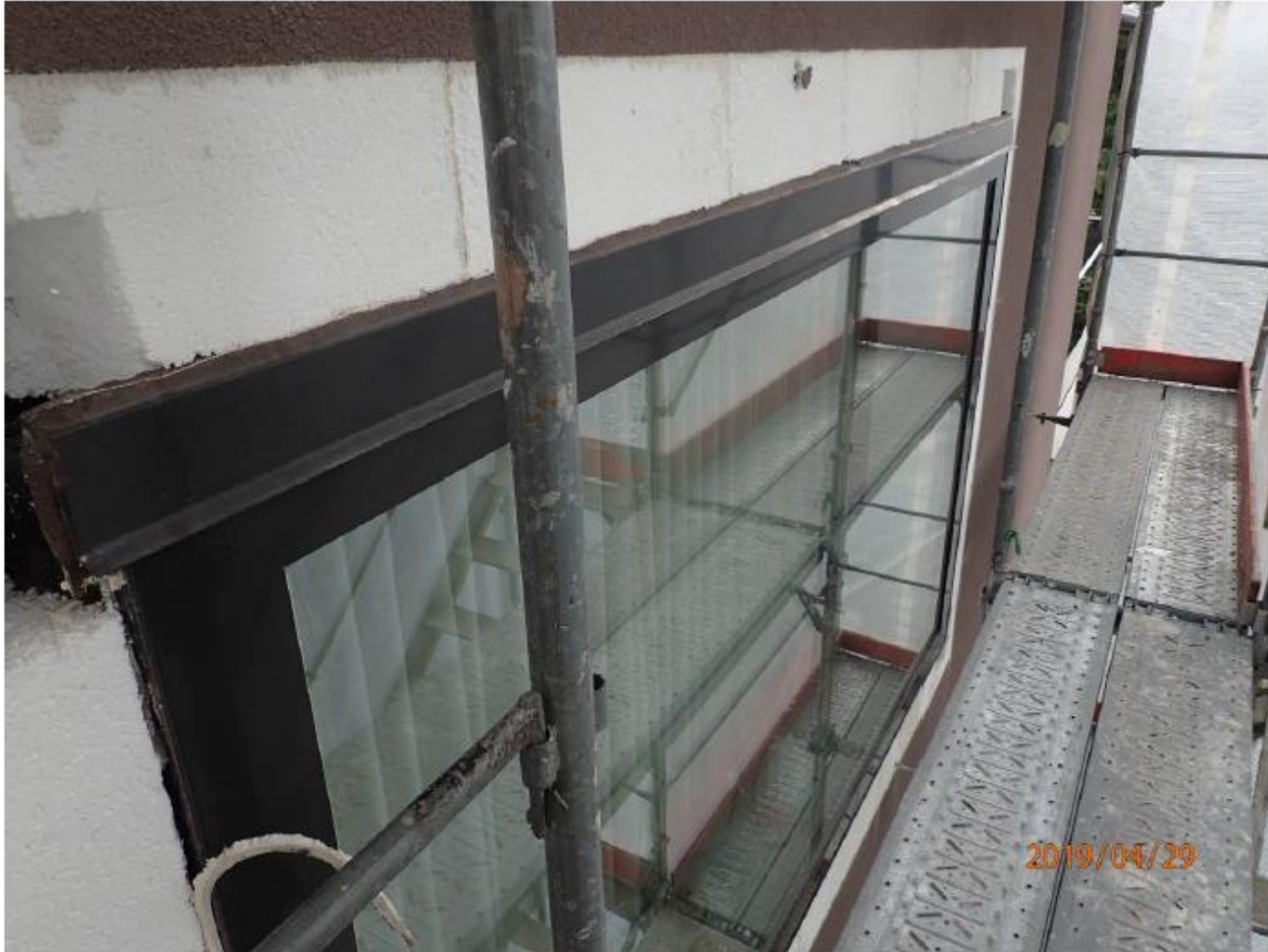
Foto 2 Freilegung und Sondierung am Fenster an der oberen Höggerstrasse 4,
