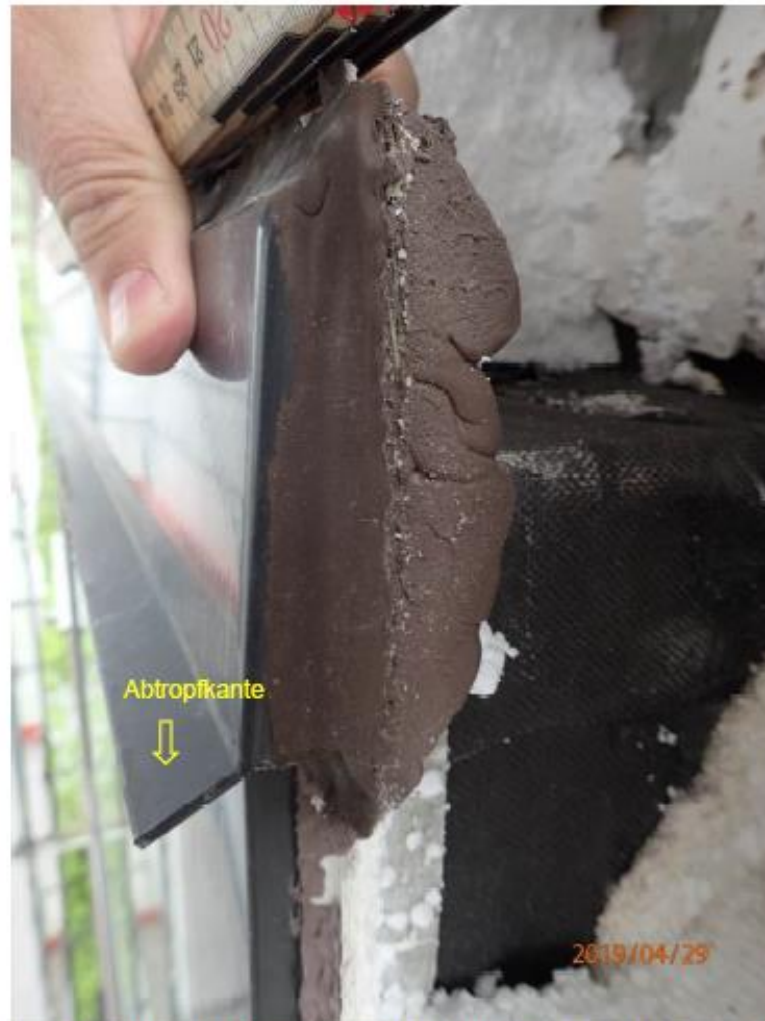
Foto 4 Die Enden des Wasserabweisbleches wurde ebenfalls grosszügig mit elastischem Kitt ausgefüllt.
