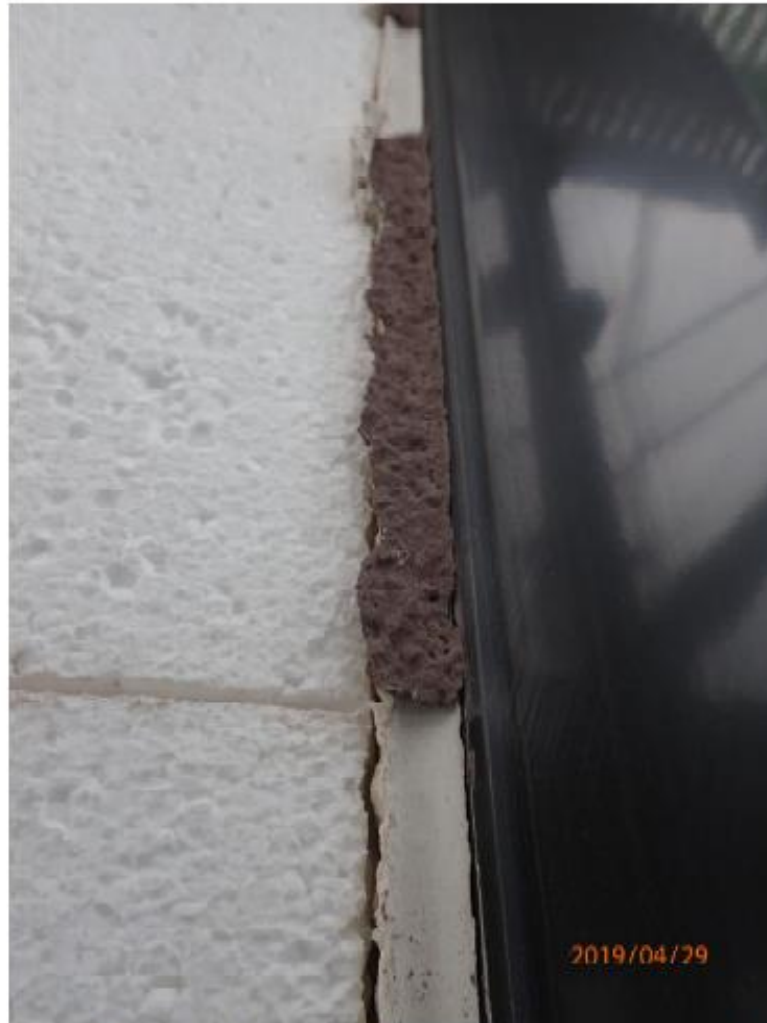
Foto 5 Der seitliche Putzanschluss wurde mit einer elastischen Kittfuge angeschlossen und mit Deckputz überarbeitet.
